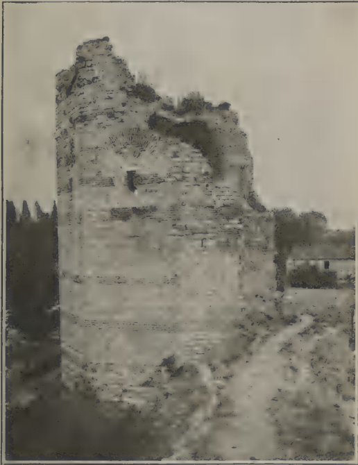
Fig. 26. Tour du mur terrestre.
